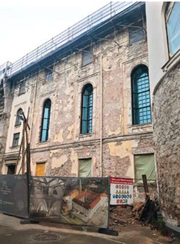
Pils dienvidu fasāde pēc jauno kapelas logu montāžas ar vēl daļēji noņemtu apmetumu.
