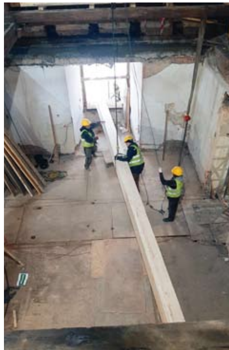
Jaunā pārseguma līmētā koka sijas iecelšana 4. stāvā.
