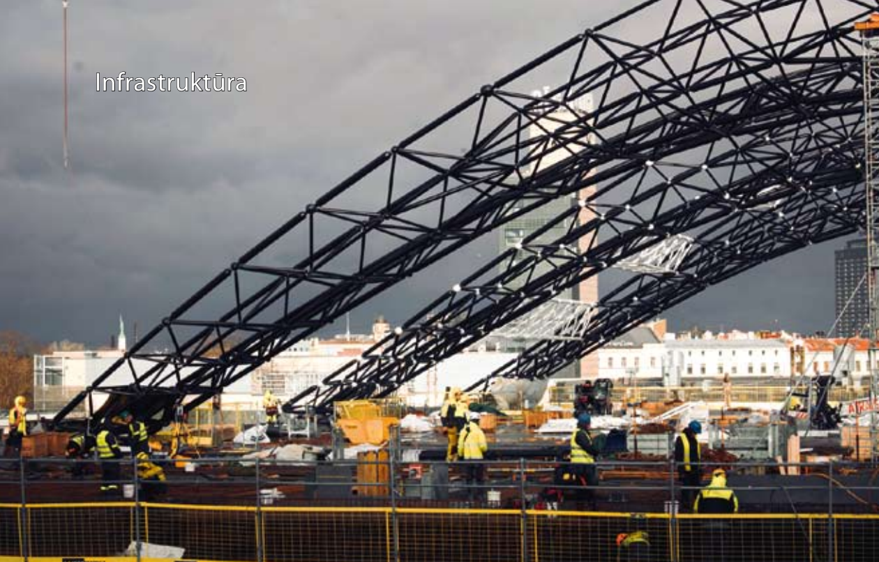
Rail Baltica Rīgas Centrālās stacijas dienvidu pusē janvārī pabeidza trešās arkas montāžu. Kopumā stacijas dienvidu (tirgus) pusē būs četras arkas, un trīs atradīsies stacijas ziemeļu jeb Rīgas centra pusē.
