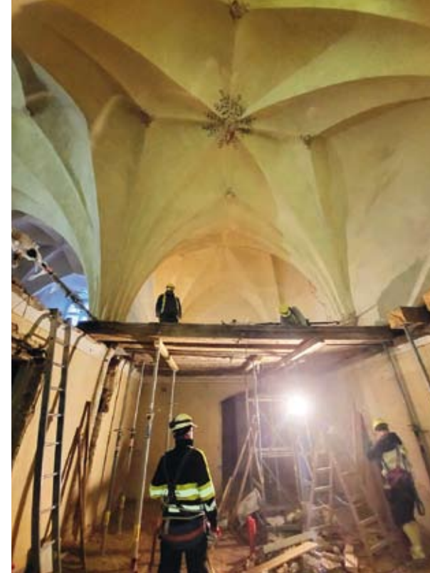
Pārseguma un sienu demontāža remtera telpā.
