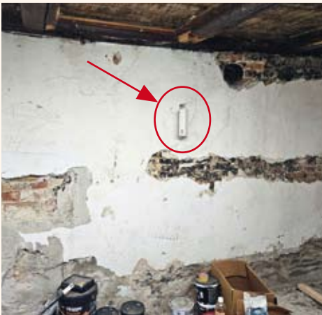
Pirms rekonstrukcijas darbu veikšanas Biodry rekomendē izžāvēt sienas.
