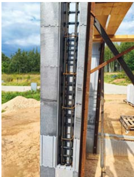
Loga ailes izbūve.
