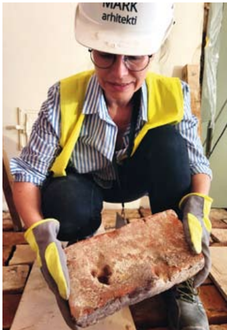
Grīdas rekonstrukcija no atgūtiem ķieģeļiem dienvidu caurbrauktuvē.
