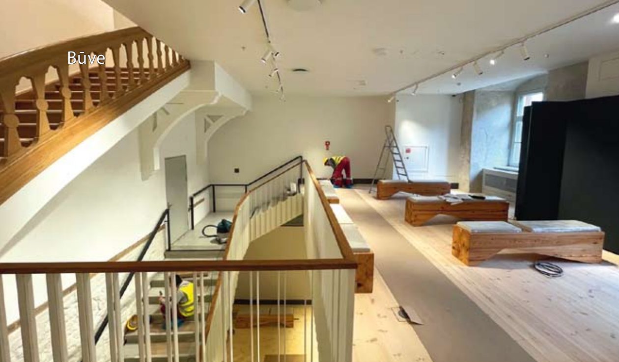
Muzeja vestibils 3. stāvā ar jauno kāpņu konstrukciju un restaurētām esošām kāpnēm.
