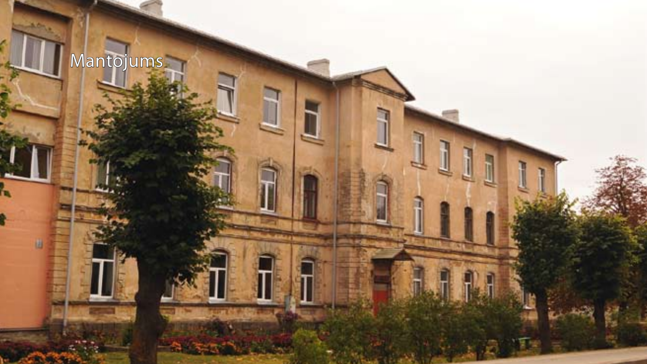
Padomju laika 20. gadsimta beigu ēkas pārveidojumi, piebūvējot trešo stāvu.
