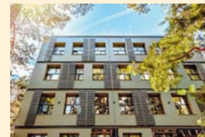
Daudzdzīvokļu ēkas rekonstrukcija – Inčukalna iela 2, Mežaparks, Rīga
