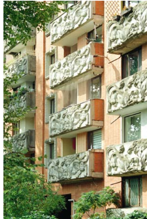
Lauvu māja Rīgā, Brīvības ielā. Arhitekta Uģa Šēnberga tēva – arhitekta Edgara Šēnberga – projekts.
