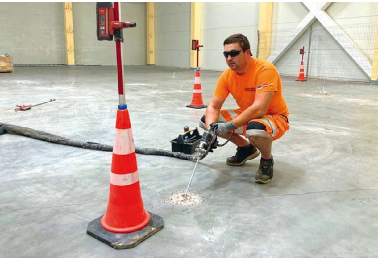
Ģeopolimēra iesmidzināšana un sacietēšanas uzraudzība.
