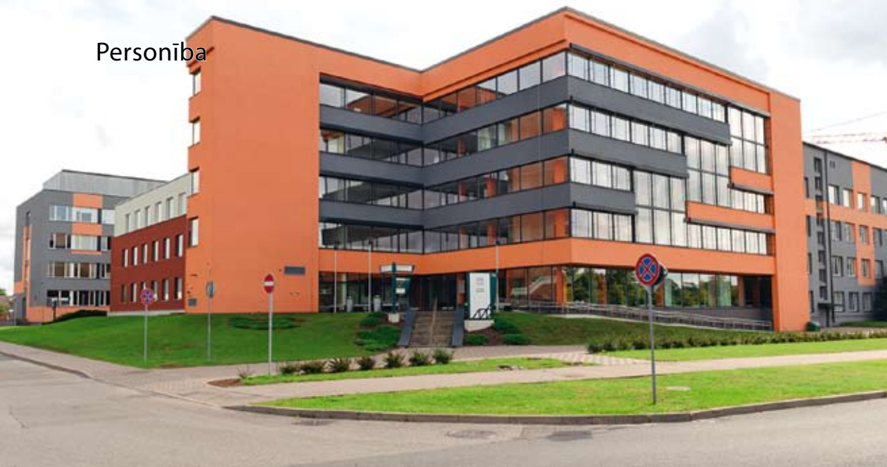
RTU Zinātniskās bibliotēkas piebūve Ķīpsalā.
