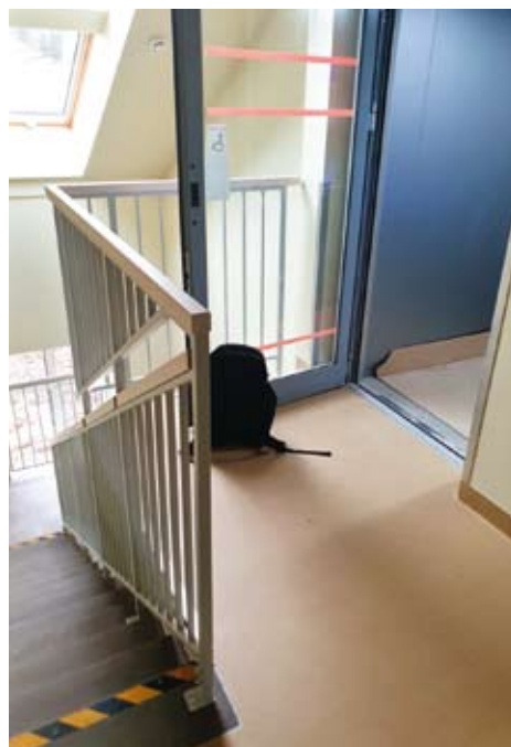
4. attēls. Nepietiekams manevrēšanas laukums (1500 mm vietā ir 680 mm).
